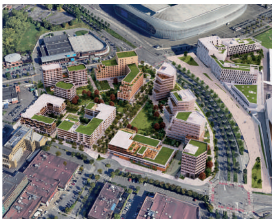
Novéa Parc project
